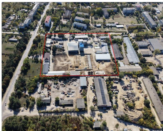
Fotografie aeriană (2026): platforma exploatată de S.R.L. „General Building”; se observă lucrări noi de construcție (fundatii, săpături)
