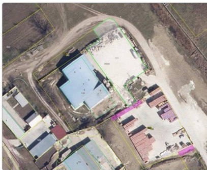
Terenul 0155213.131 (0,15 ha) – proprietate publică, alăturat, folosit ca platformă/curte
